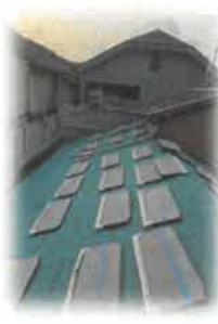
雨漏れしている部分があり修理も検討されましたが、耐震補強工事の対象になることから、屋根の葺き替え工事を行いました。
